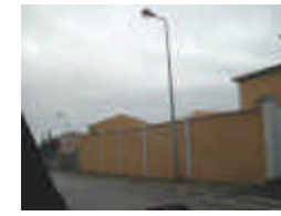
Les clôtures emmurées
