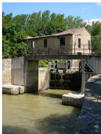
Écluse et moulin de Gua : zone de transition entre les séquences urbaines et rurales
